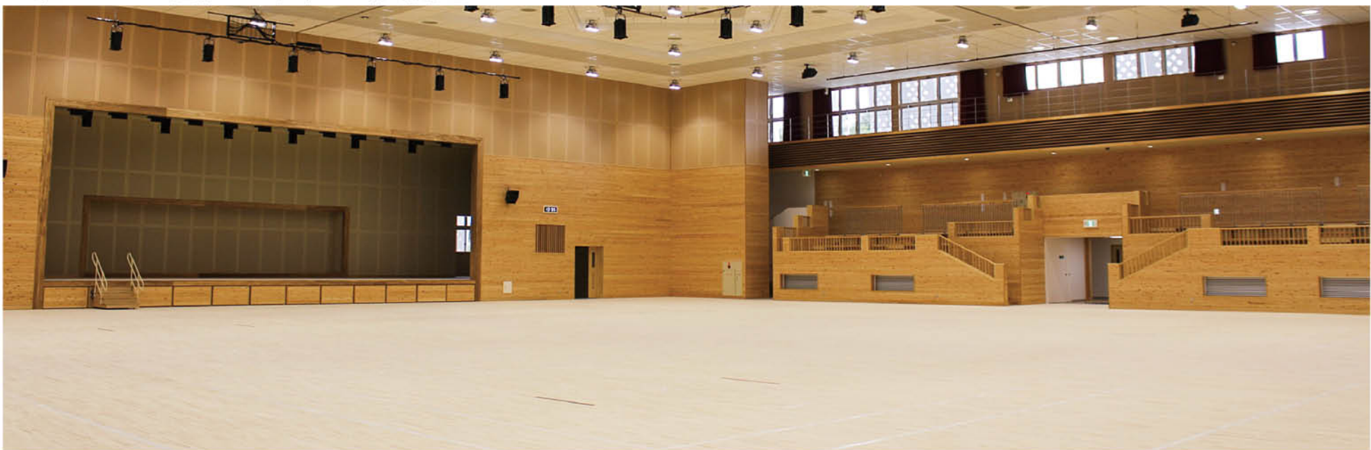
沖縄空手会館 マツ集成フローリング (無節) 18mm / 1,820㎡ 防虫防蟻処理
