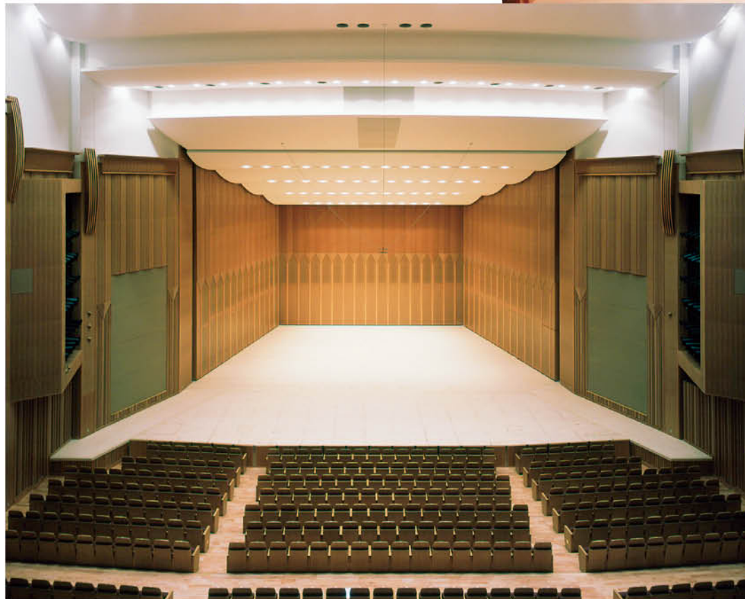
宮崎県都城市総合文化ホール ヒノキ集成フローリング（無節） 24mm / 531㎡
